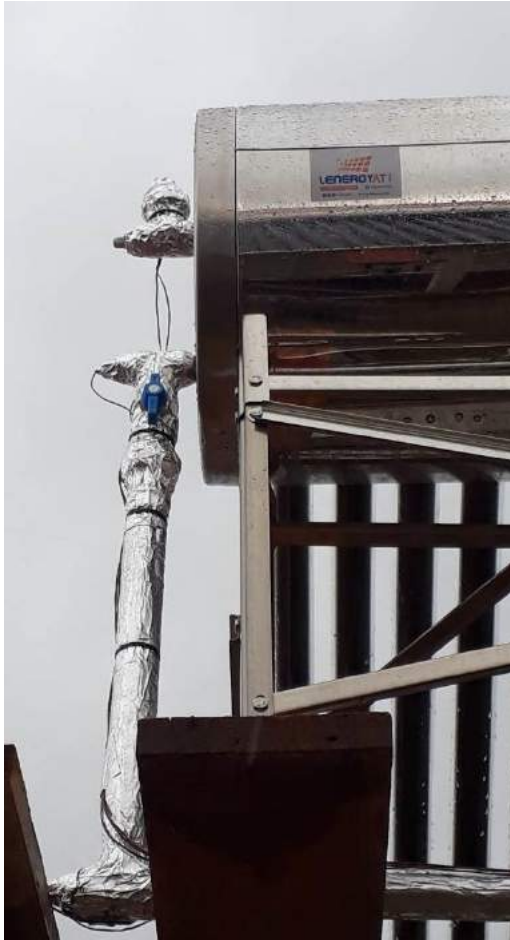
Figuras 69 y 70. Todas las conexiones de tubería fueron completamente cubiertos con aislamiento térmico. Se muestran también algunos puntos de acceso de los sensores de temperatura.
