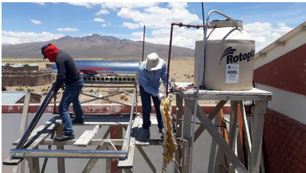
Figura 66. Trabajos de reparación y mantenimiento de la terma solar.
