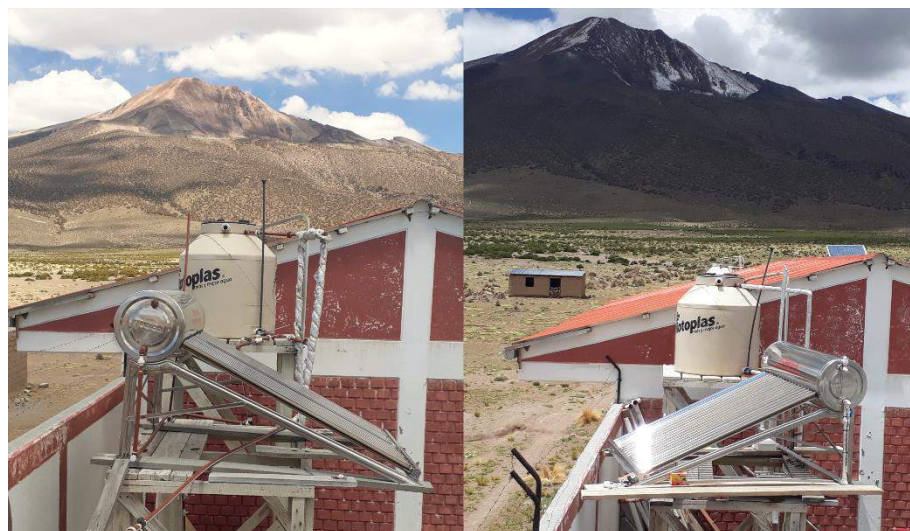
Figura 25. Fotografía de la terma solar antes (izquierda) y después (derecha) de los trabajos de reinstalación.
