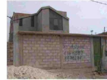
LOTES EDIFICADOS CON BLOQUETA Y LADRILLO: 27.8 % del total de lotes.
