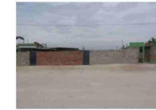
LOTES CON SOLO SERCO PERIMETRICO: 4.2 % del total de lotes.
