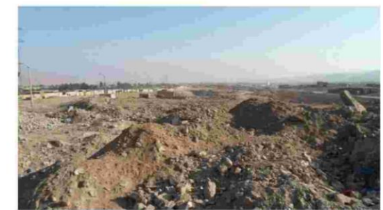
DEL TERRENO ESTADO SUELO CON RELLENO
