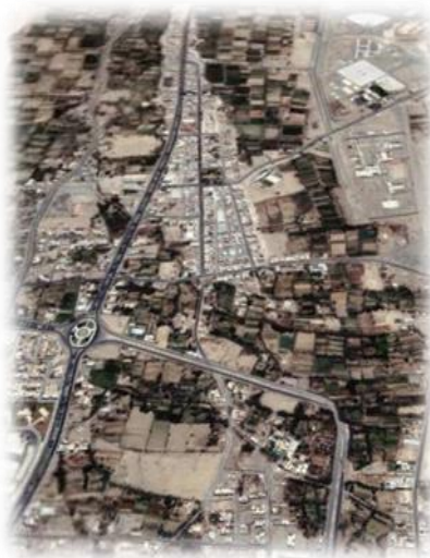
Figura N° 47 Vista aérea Av. Celestino Vargas Fuente: Google earth
