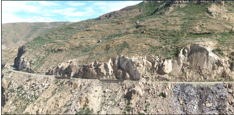
Figura 3.3. Vista panorámica desde la progresiva km 124+580 – km 124+860 donde observa el afloramiento de las tobas dacíticas.
