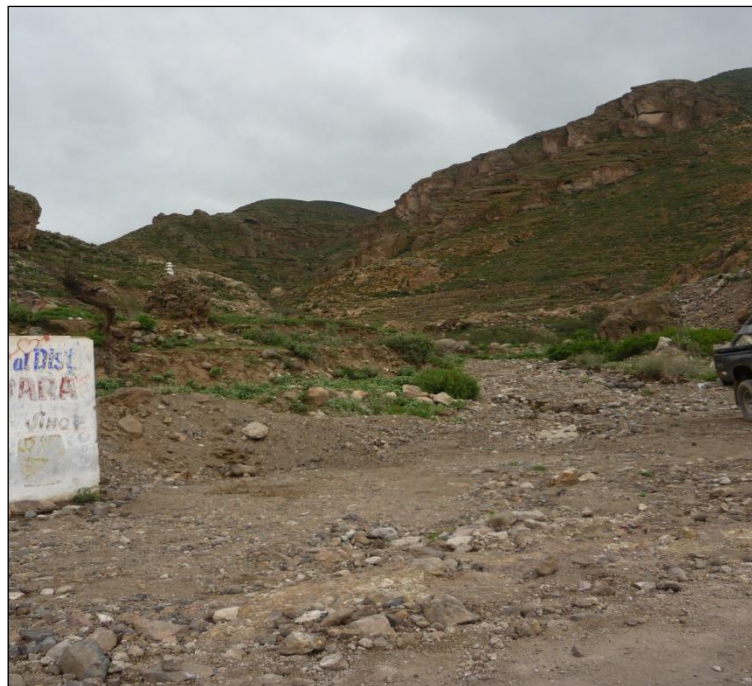
Figura 3.7. Vista en el cruce al pueblo de Sitajara, en el km. 125+400, donde se puede apreciar depósitos fluviales cortando al trazo de la carretera.
