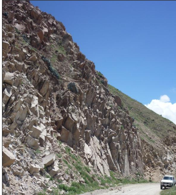
Figura 3.9. Vista en el km. 128+500 al km 129 +000 de los afloramientos volcánicos de la formación Huaylillas, se encuentran Muy fracturados, presentando roturas tipo vuelco y planares.
