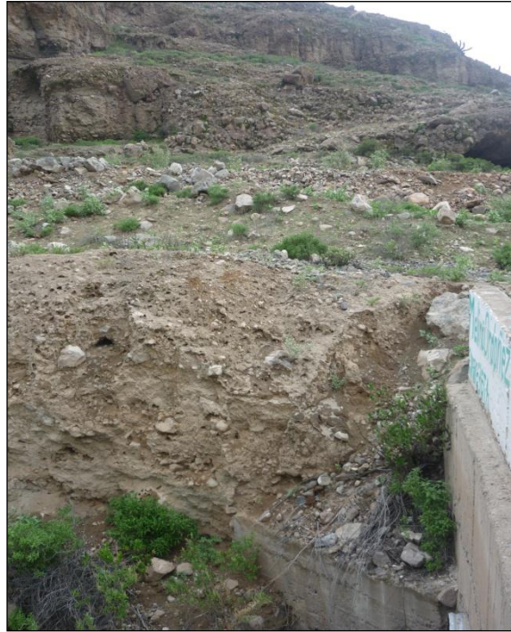
Figura 3.5 Depósito Aluvial, en el km. 125+400 se aprecia una secuencia basal de conglomerados en una matriz de limo arenas, propio de una llanura de inundación.
