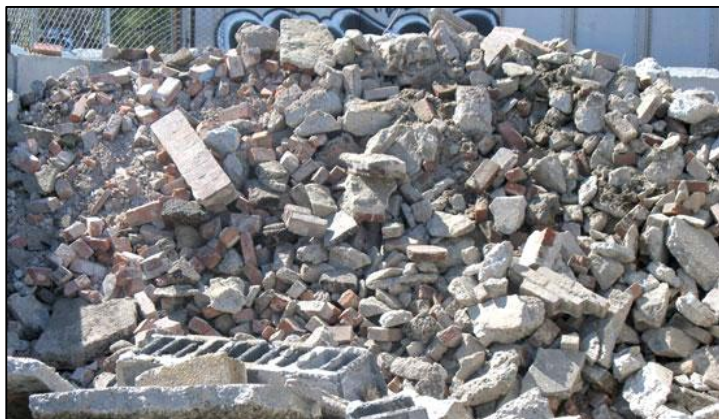
Imagen N°07: Residuos de demolición
