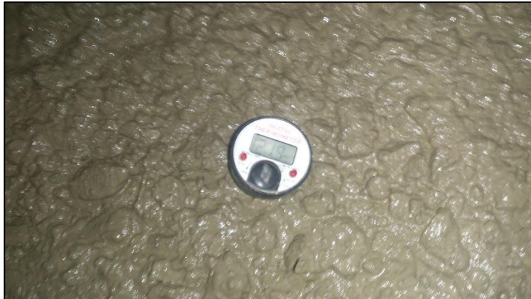
Imagen N°44: Exudación del concreto
