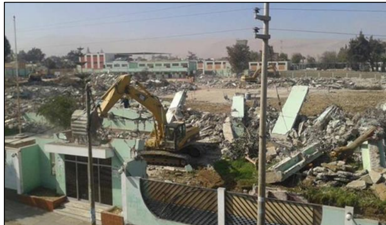
Imagen N°22: Demolición del colegio FAZ
