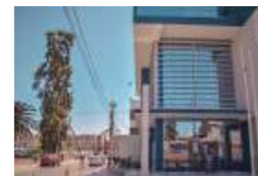
Edificación nueva construida de concreto armado
