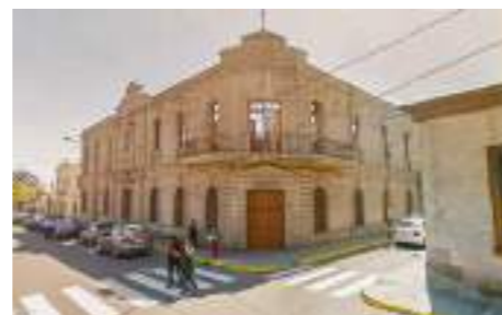
Ex Gobernación: Estado de Edif. Malo
