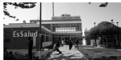
Imagen: SALUD- Essalud Fuente: Elaboración propia.
