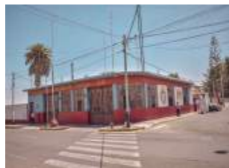
Estación de Bomberos: Estado de Edif. Bueno
