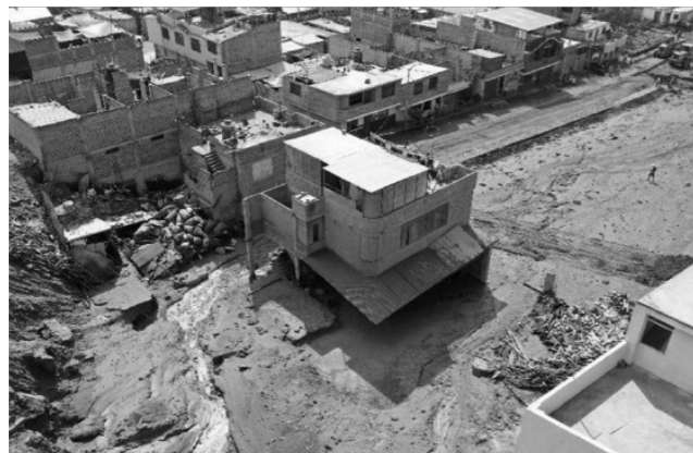
Figura: Aluvión ocurrido en la zona de La Florida, Tacna. Fuente: RCR, 24 de febrero de 2020.
