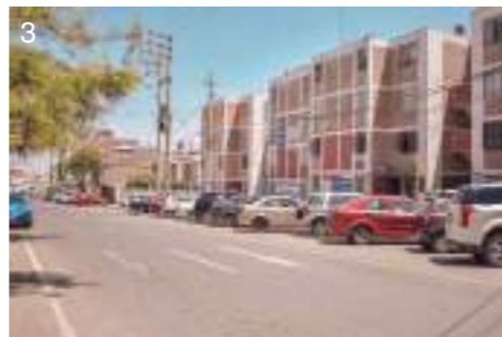
Edificaciones de 04 - 05 niveles: Ca. Presbítero A.
