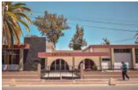
Edificaciones de 1 nivel: Calle Crnl. Inclán
