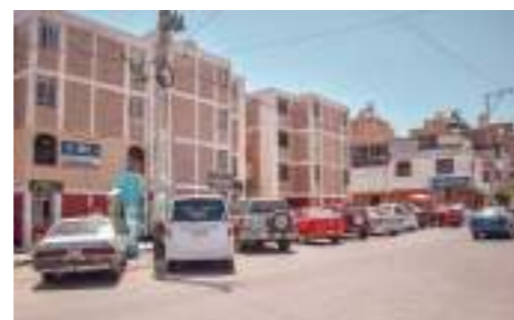
Zona Residencial: Estado de Edificación Regular
