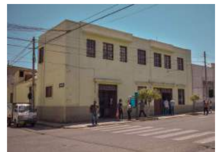
Edificación hecha de adobe
