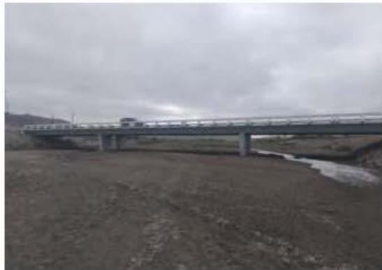
Figura 2. Zona de muestra 1. Puente Fuente y elaboración: propia.
