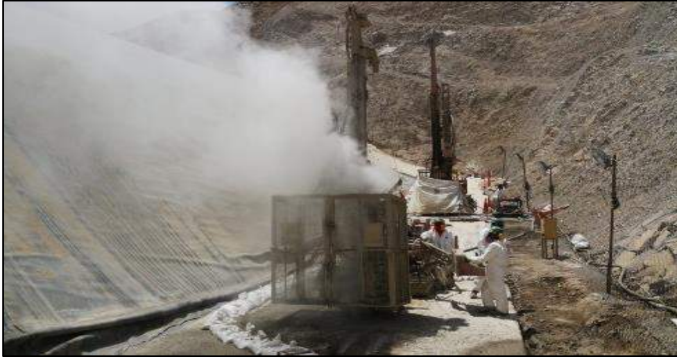
Nota. Se muestra perforación rotoperkusiva, con máquina Futuro Drill.
