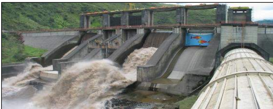
Presa de derivación
