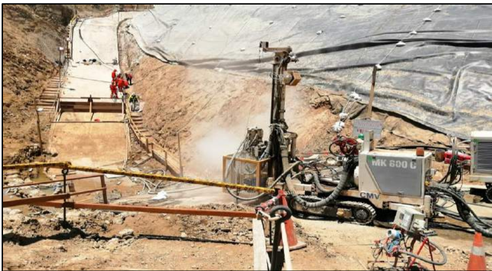
Nota. Se muestra perforación rotoperkusiva, con máquina MK-800.
