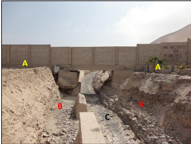
Foto N°02. Se aprecia la conformación de los diferentes tipos de lecho, A: Lecho Mayor o de inundación B: Lecho Ordinario o aparente C: Lecho o canal de estiaje.
