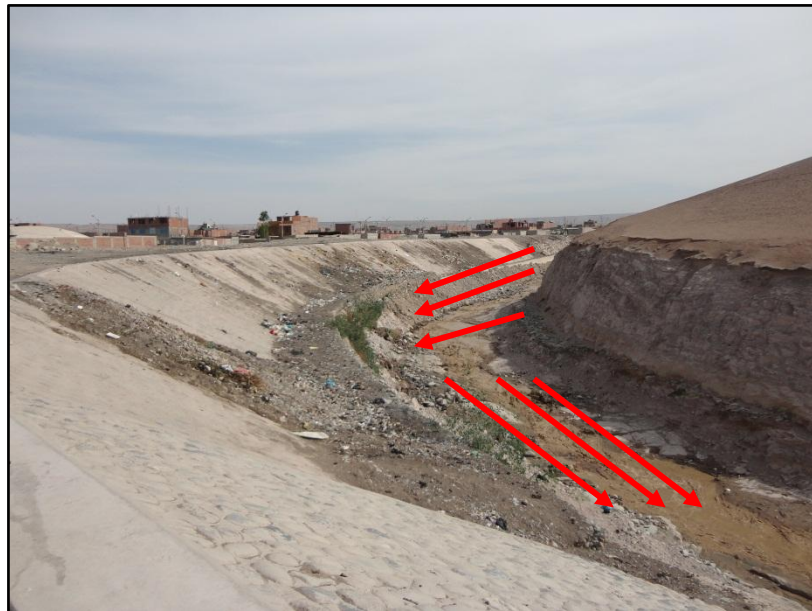
Foto N°15. Mecanismo de erosión y sedimentación del meandro ubicado entre las progresivas 1+080 y 1+200.
