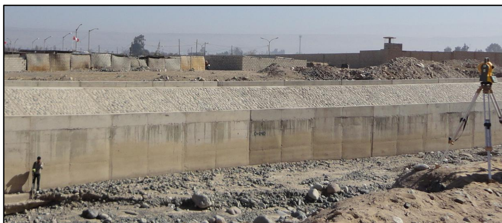
Foto N°18. Se observa equipo de estación total marca TRIMBLE modelo 3600 DR.
