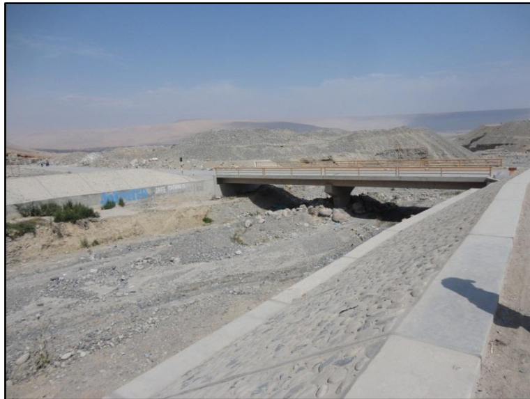
Foto N°20. Vista donde se aprecia el puente de acceso a la zona de canteras
