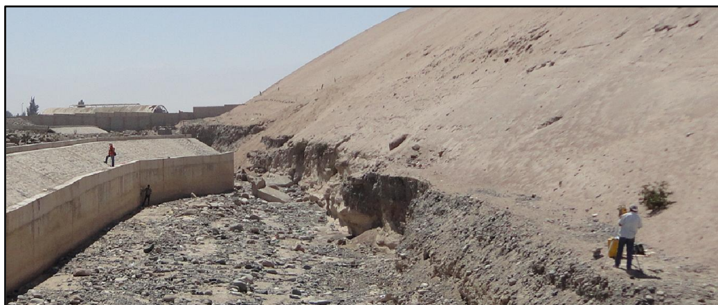
Foto N°17. Se observa el levantamiento topográfico en campo de los asistentes y el topógrafo en la zona de las márgenes y el lecho.
