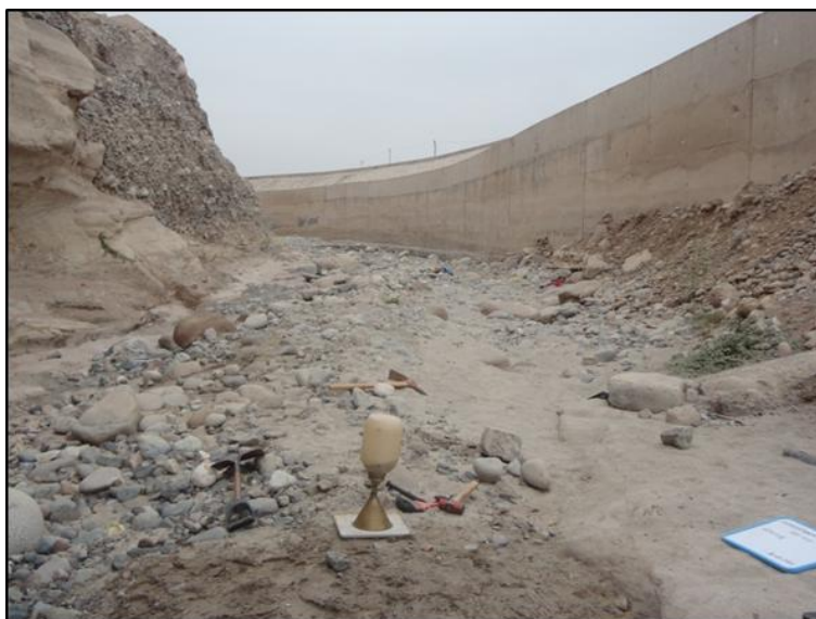
Foto N° 08 Vista donde se observa el ensayo de densidad in situ en la base del lecho del río profundidad del hoyo 0,15 m.
