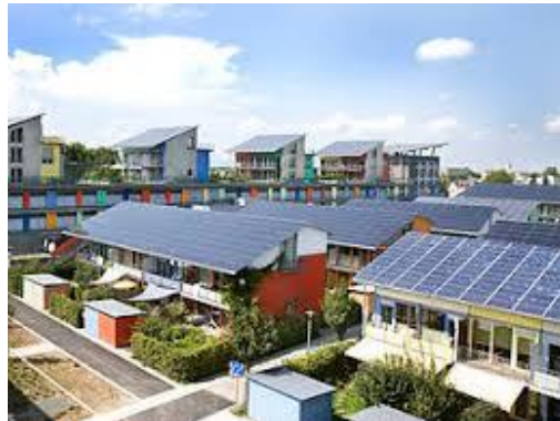
Imagen 15: Energía Solar Fotovoltaica
