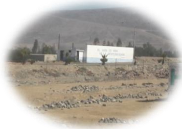
Reservorio de agua
