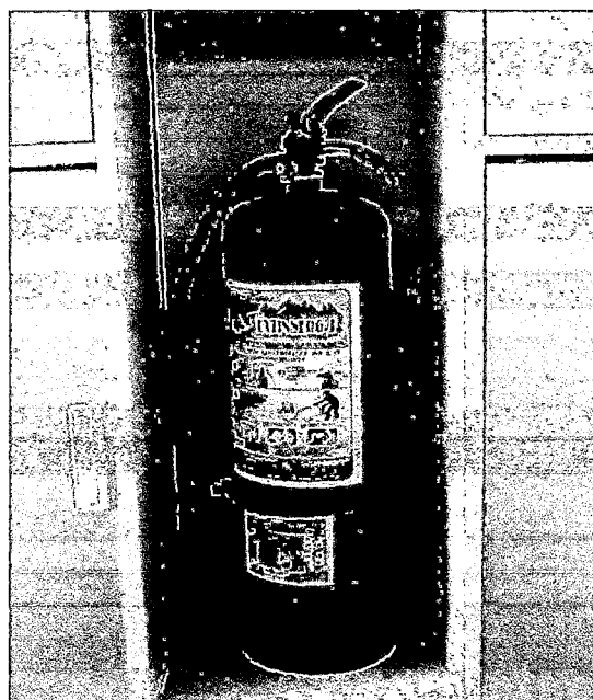
FOTO 06: EXTINTOR CONTRA INCENDIOS
