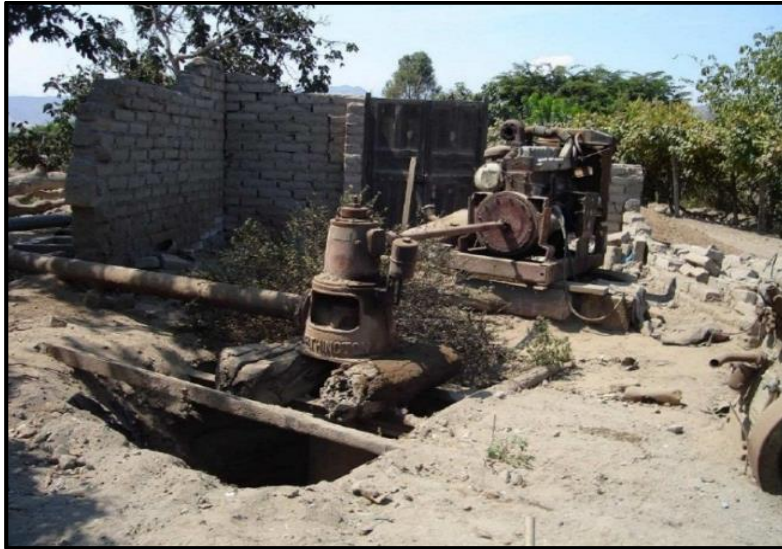
Figura 2. Estación de bombeo de agua subterránea abandonado en la Yarada - Tacna
