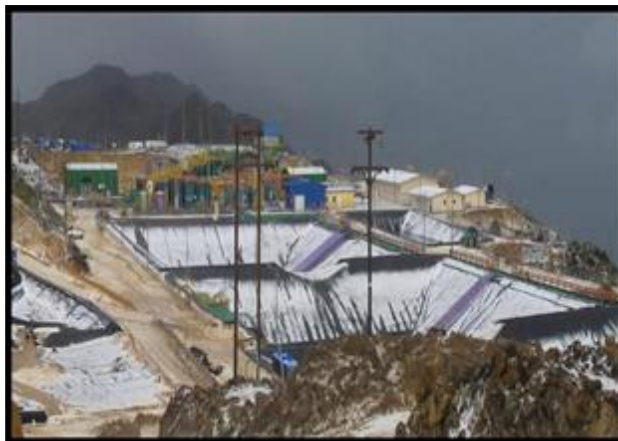
Figura 8: Planta ADR (Adsorción/Desorción/Regeneración) Fuente: Geología minera La Zanja
