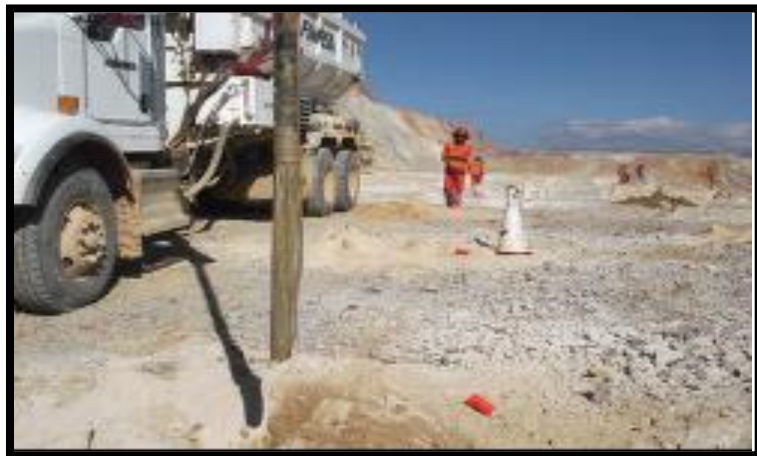
Figura 19. Muestra la imagen de un camión fábrica, fabricando SAN-G
