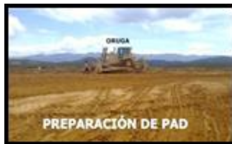
Figura 3: Nivelación de las celdas del Pad Fuente: Geología minera La Zanja
