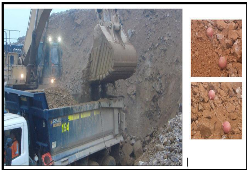
Figura 39. Proceso de voladura y remoción de material volado Fuente: Asistencia técnica Famesa explosivos 2 014
