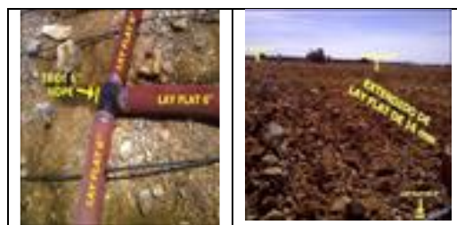
Figura 5: Tendido de sistema de tuberías sobre las celdas de lixiviación
