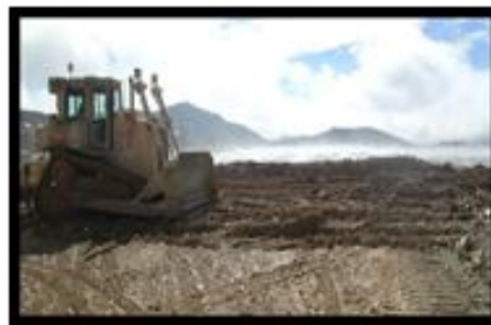
Figura 4: Ripeado de las celdas del Pad Fuente: Geología minera La Zanja
