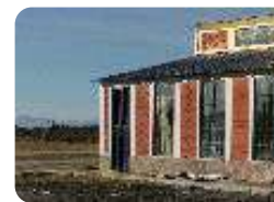
Local de Ladrillo
