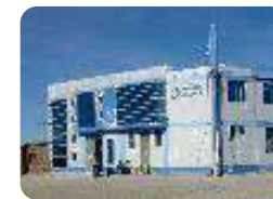
Edificación con muros de mampostería y estructura armada
