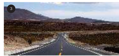
Tramo III – Empresa ICCGSA
