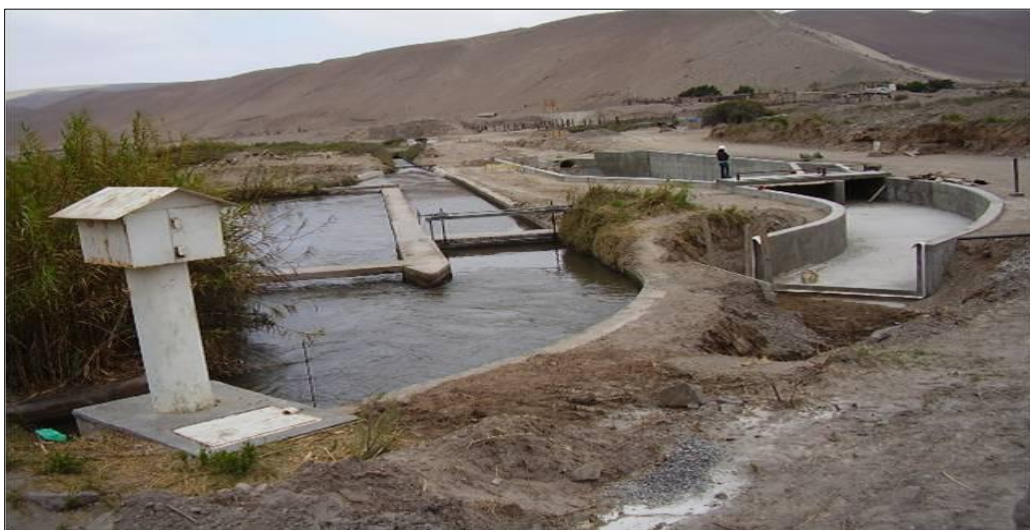
Figura 43. Fotografía de la bocatoma y desarenador Ite
