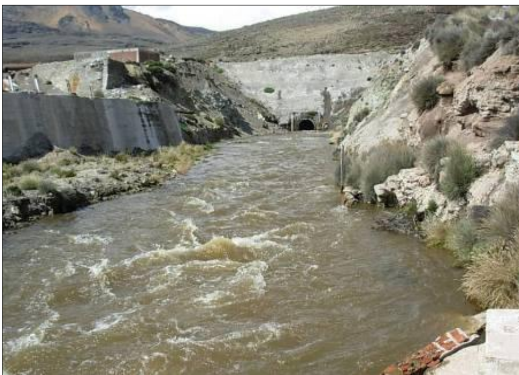
Figura 39. Fotografía del portal de salida del túnel Kovire
