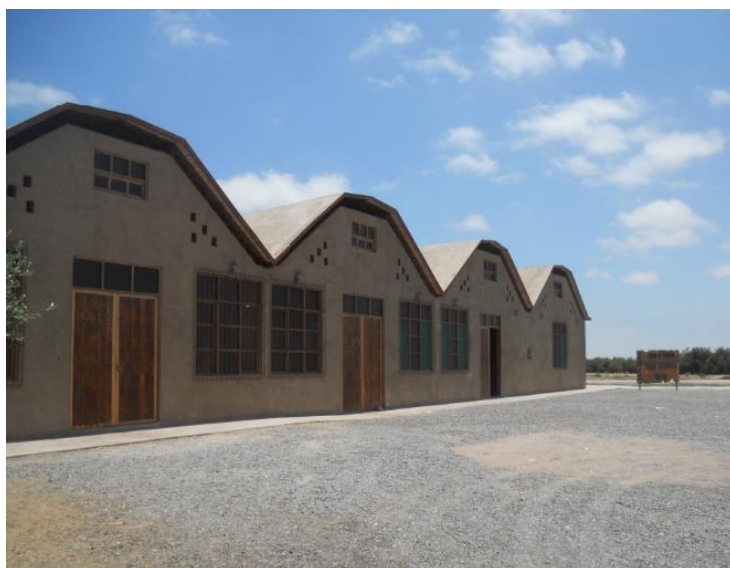
Figura 2. Vista externa de la Bodega del I.E.T.S.P. Centro de formación agrícola Tacna
