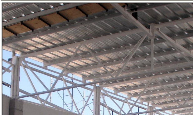
Estructura de cobertura Metálica
