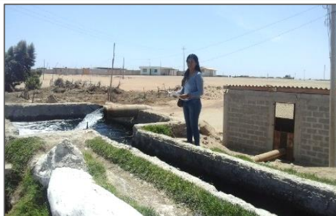
Vista del pozo IRHS 54 –Agua
