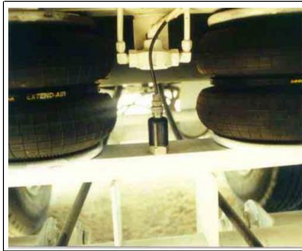
Figura 36. Acelerómetro fijo a la estructura de base atornillada Fuente: http://imt.mx/archivos/Publicaciones/PublicacionTecnica
