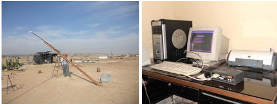
Figura 29. Retiro del microaerogenerador y descarga de la información del datalogger.
