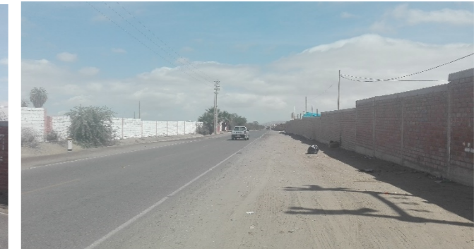
Sistema Constructivo - Cerco Perimétrico UNJBG.
