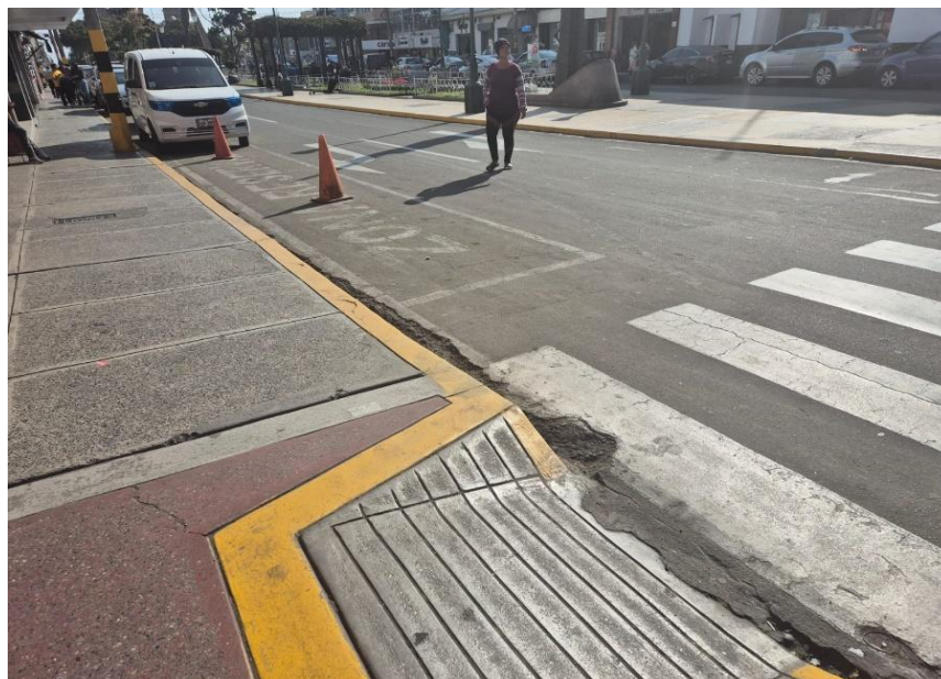
Foto 2: En la imagen se aprecia la materialidad existente en la zona de estudio, esta cuenta con veredas de concreto, con una pista asfaltada. Y la parte central de Paseo Cívico de (nombre de Material). Esta toma fue realizada en la Esquina de la Av. San Martín y Calle Apurímac frente al Ex Palacio Municipal.
