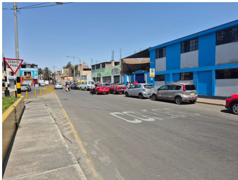
Foto 7: En la imagen se aprecia la fachada de la I.E. REPUBLICA ARGENTINA, esta cuenta con vereda. La captura fue realizada durante el proceso de trabajo.
