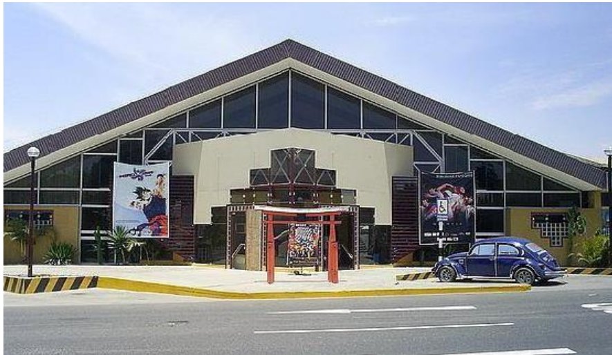
Nota. Fachada exterior del centro de convenciones de Tacna.
