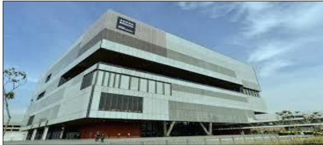
Fachada de Centro de Convenciones de Bogotá
