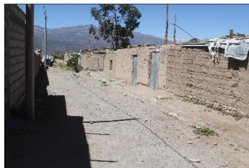
Figura N° 22: Vías en la periferia se encuentran en mal estado.
