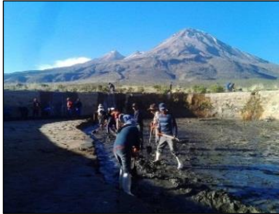
Figura N° 56: limpieza de reservorios
