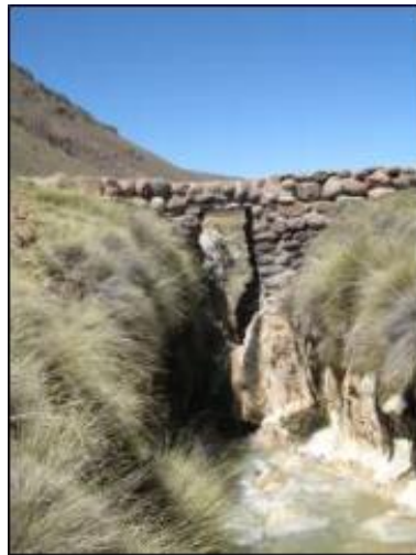
Figura N° 72: Puente de piedra
