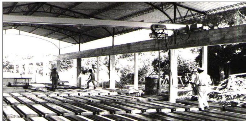
Imagen 7: Planta de prefabricado ubicado en Zona
