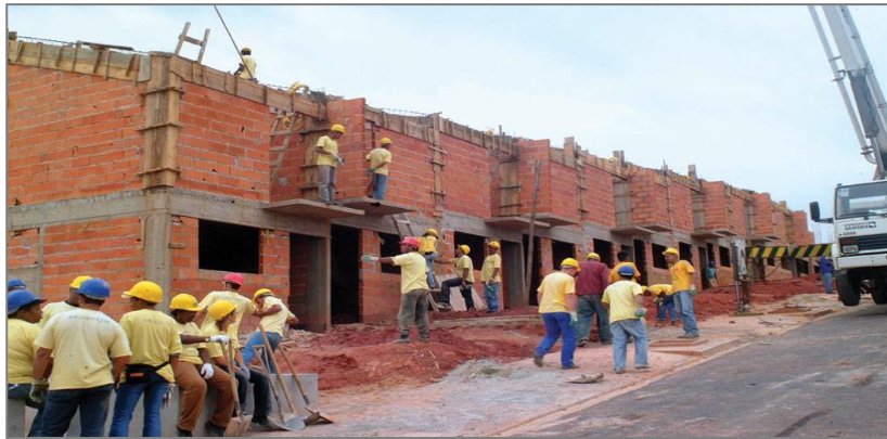
Imagen 8: Ayuda mutua en la construcción durante Jornada Solidaria
