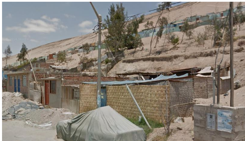
Imagen 17: Viviendas precarias ubicadas en falda de cerro Intiorko
