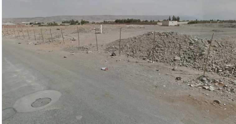
Imagen 28: Buzón de desagüe en la Av. Vilauta
