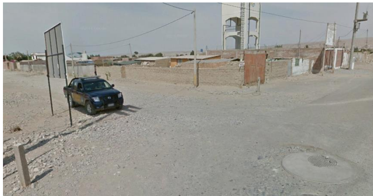
Imagen 29: Buzón de desagüe en la Av. Vilauta y la vía auxiliar s/n frente a J.V. Santa Rita.
