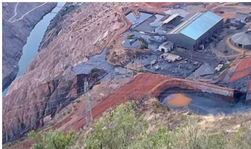
Fuga de relaves en mina Cobriza
