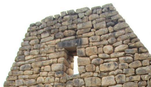
Figura 50. Ventana en el hastial, Ventana de segundo piso en el hastial del Recinto, Sector Occidental Superior
