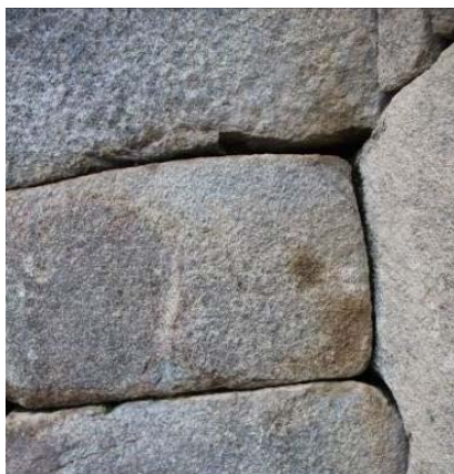
Figura 43. Asentado encimado, muro interior de Casa del Inka
