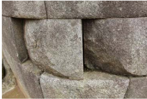
Figura 46. Asentado encajado, muro circular, Templo del Sol
