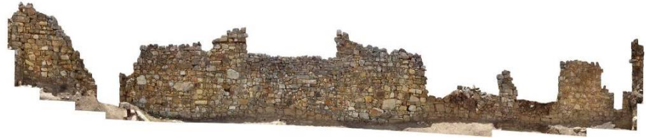
Figura 21. Levantamiento de paramento con fotogrametría de objetos cercanos.
