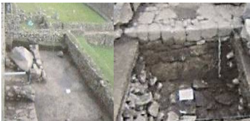
Figura 93. Excavación la unidad de excavación 8 y 9 del Sector II, subsector c, patio del contorno de la Casa del Inka.
