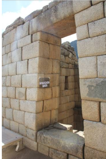
Figura 48. Apertura externa del Recinto lateral, Templo del Sol
