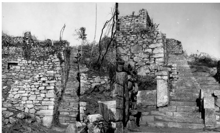
Fotografía 20. Escalera Central entre el Subsector A y B Fuente: Ministerio de Cultura (2015)
