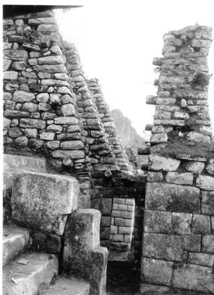
Fotografía 4. Ingreso lateral de la
