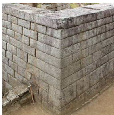
Figura 36. Perfil plano, muro externo. Templo del Sol
