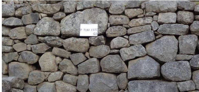
Figura 59. Aparejo rústico, Subsector Extensión Templo del Sol
