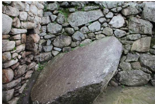
Figura 42. Asentado adosado, Muro interior Recintos Occidentales
