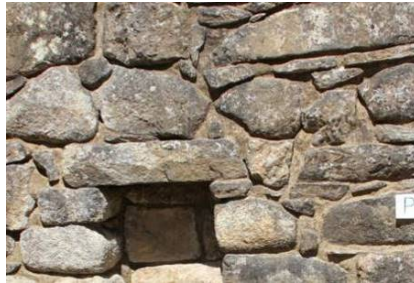
Figura 28. Estado piedra desbastado, Recinto Occidentales superiores del Sector II
