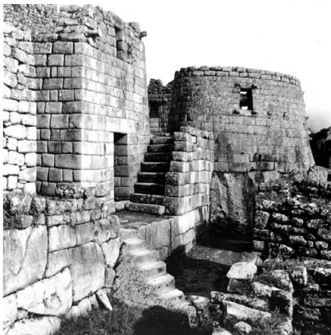
Fotografía 18. Vista del acceso por las plataformas al Recinto 4 y 5
