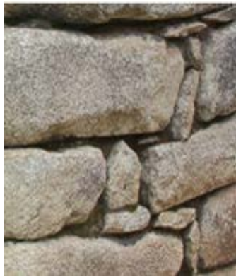
Figura 44. Asentado acuñaado, muro interior Recintos Orientales Superiores
