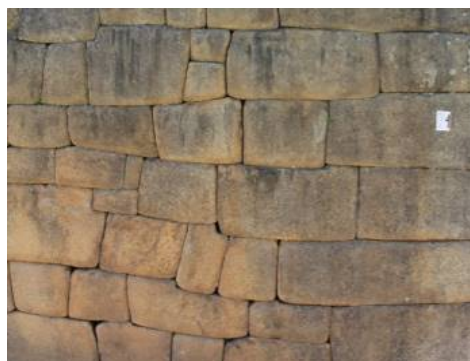
Figura 29. Estado piedra canteada, muro exterior Casa del Inka
