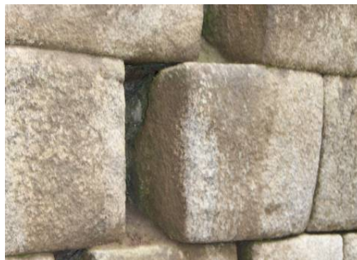
Figura 38. Mortero amarillento homogéneo, muro interio del recinto colindante del Templo del Sol
