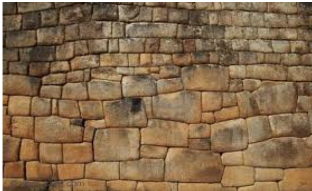
Figura 61. Aparejo con diseño, Subsector Plaza Principal
