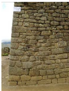
Figura 33. Perfil desbastado, muro de recinto en el Subsector Occidental Superior
