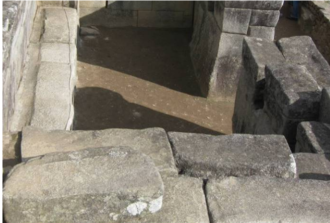
Figura 45. Asentado adintelado Muro exterior del espacio posterior del Templo Mayor
