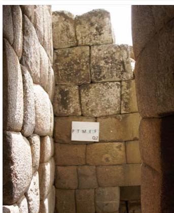
Figura 34. Perfil almohadillado, puerta del Subsector Casa Inka
