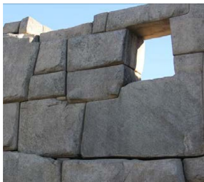
Figura 47. Asentado engastado, Templo Tres Ventanas
