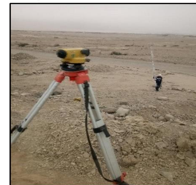
En la imagen se puede observar trabajo de nivel del terreno eriazo.
