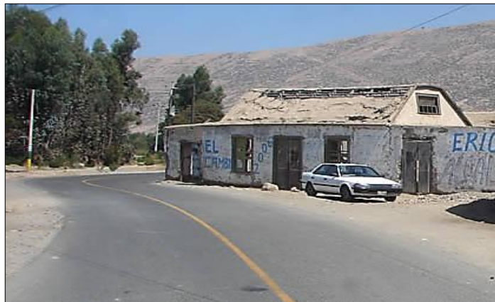
Figura 36: Vivienda tradicional del Distrito de Calana
