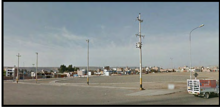
Cableado eléctrico, alumbrado y telefónico
