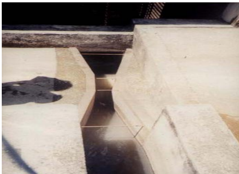
Figura 17. Canal de Parshall
