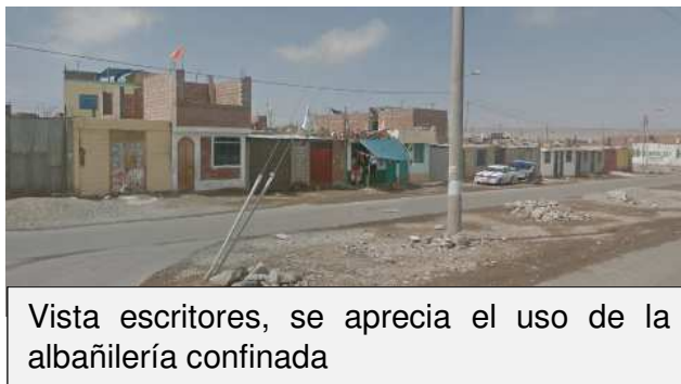
Figura N° 71: Tecnología de construcción
