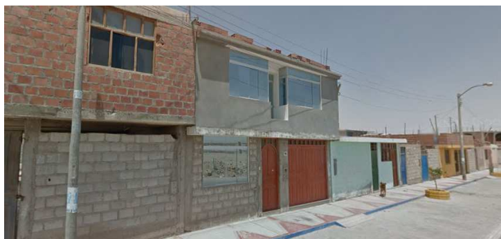
Figura N° 54: Estado de edificación
