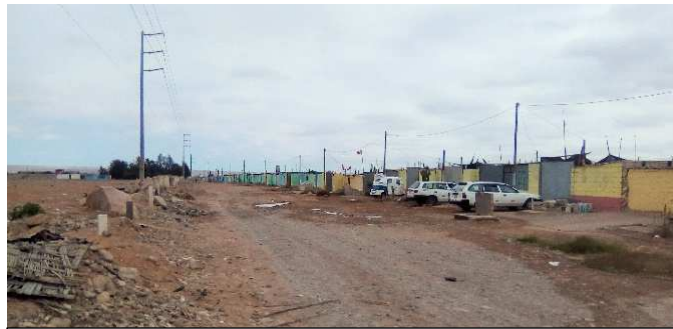
Figura N°61: Vía Secundaria Av. El Deporte
