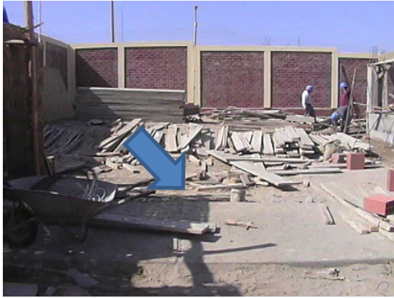
Residuos de Maderas.
