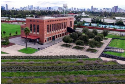
Figura N°12 : Vista de la infraestructura hecho de ladrillos
