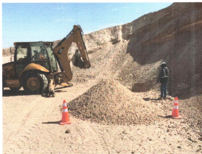
Fotografía 16 Excavación de la calicata C-04
