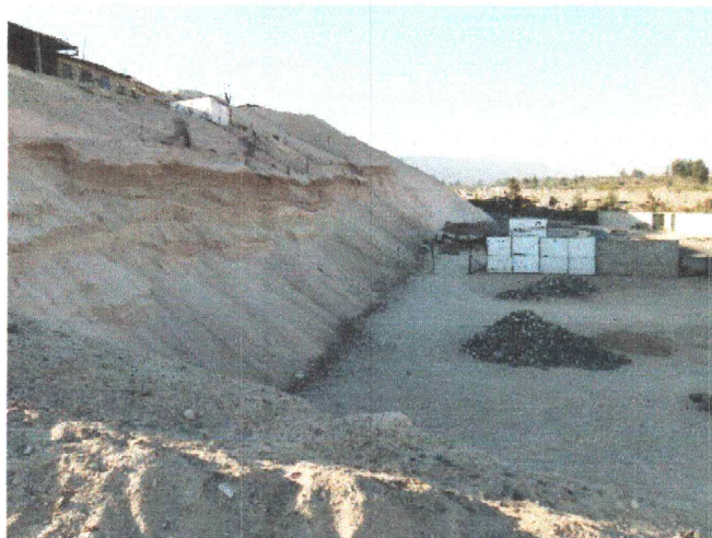
Fotografía 2 Vista del talud existe en el área de estudio
