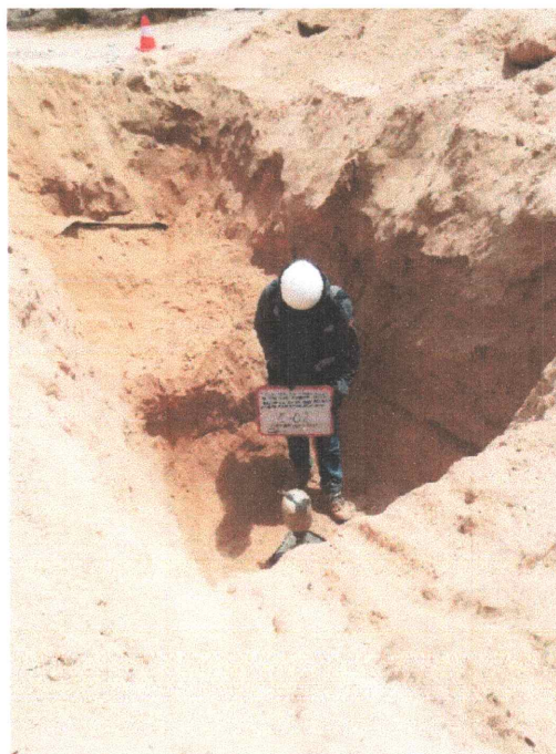
Fotografía 13 Ensayo de densidad In situ en la calicata C-02
