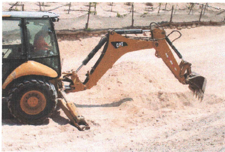
Fotografía 12 Excavación de la calicata C-02
