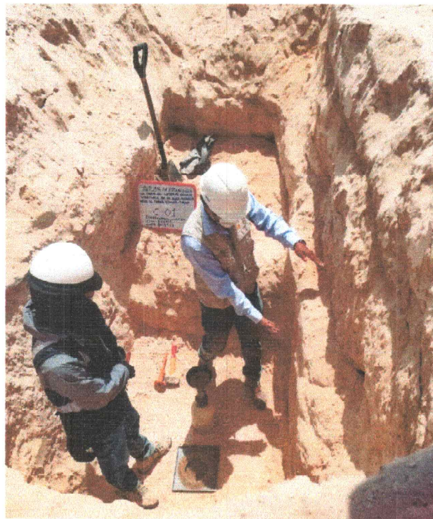
Fotografía 9 Vista del registro de la calicata C-01
