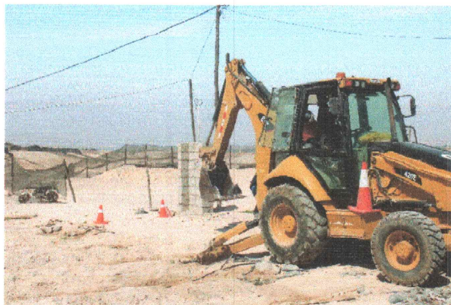
Fotografía 8 Excavación de la calicata C-01
