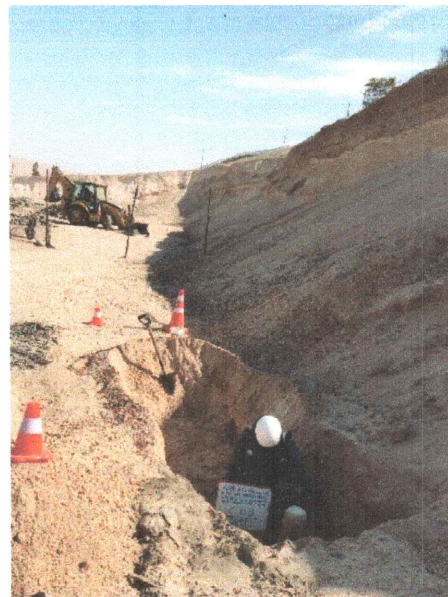
Fotografía 18 Excavación de la calicata C-05
