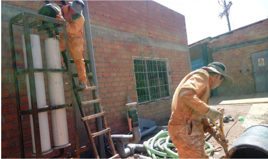
Figura 21. Carguío de las columnas de Lixiviación Fuente: Elaboración propia
