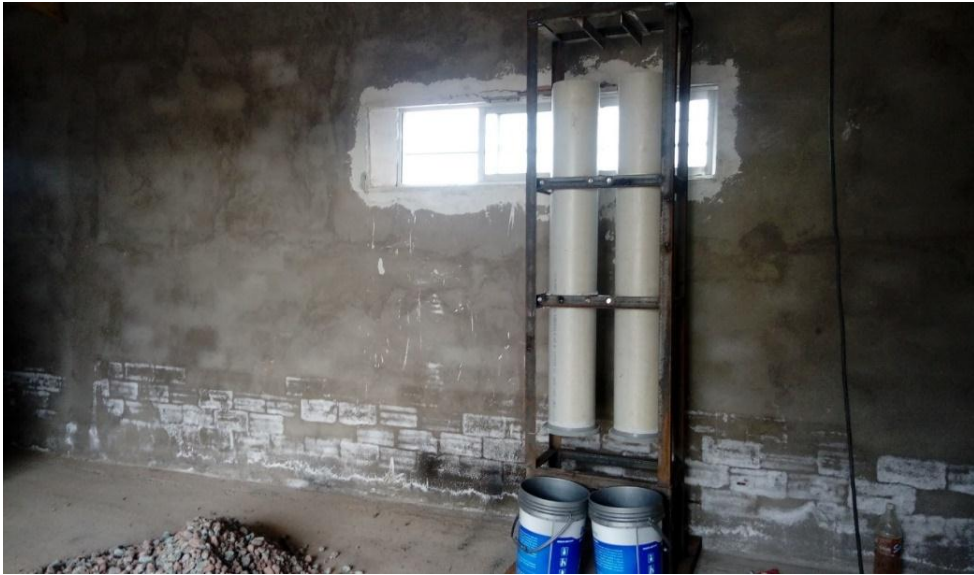
Figura 20. Instalación columnas de Lixiviación Fuente: Elaboración propia
