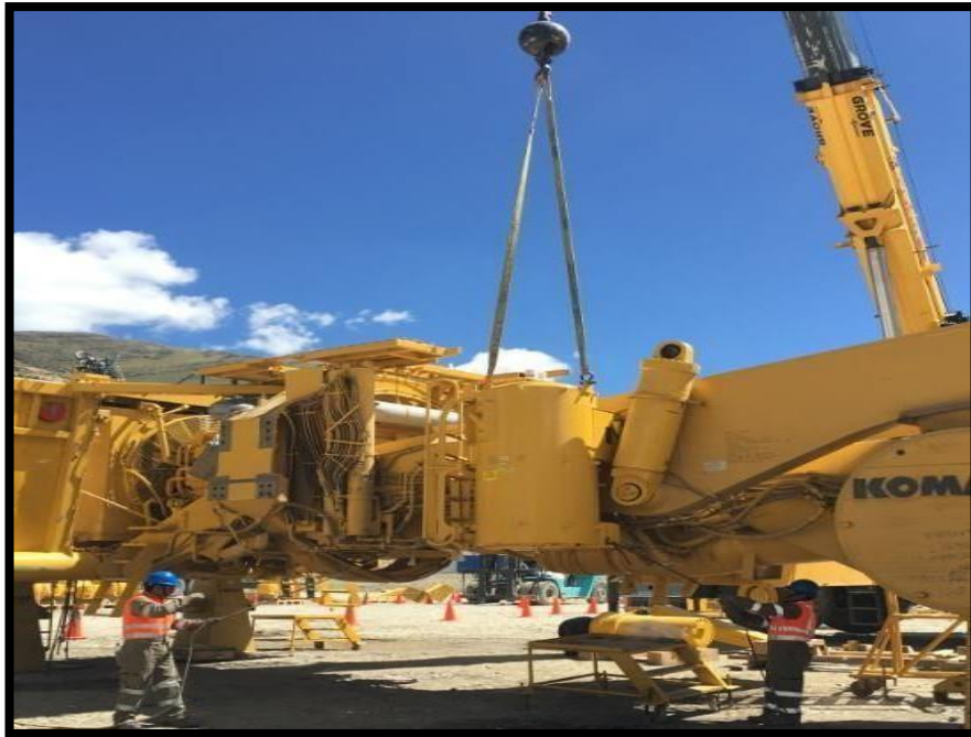
Figura 15: Instalación de tanque hidráulico (250 galones)
