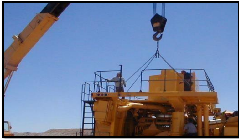
Figura 27: Instalación de plataforma superior
