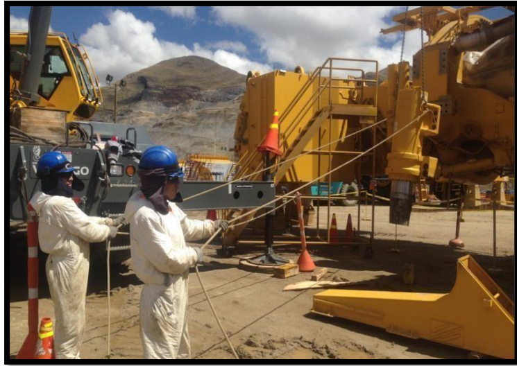
Figura 17: Instalación de suspensión frontal posición LH
