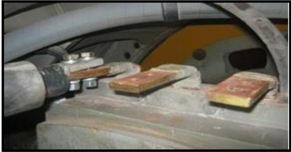
Figura 35: Instalación de líneas eléctricas en mando final
