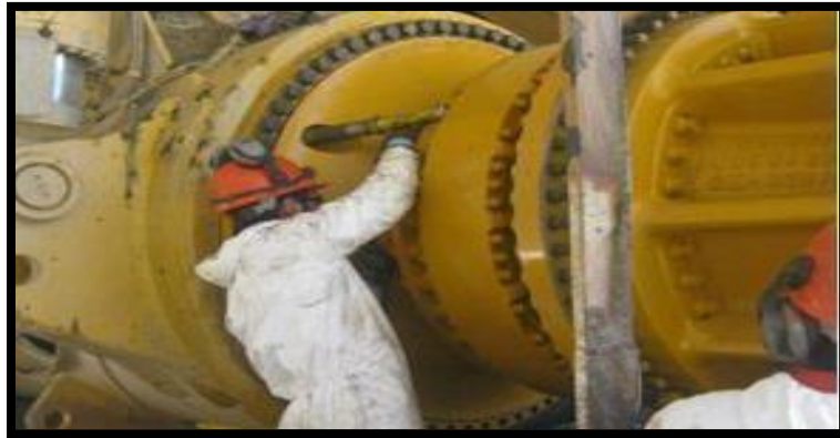
Figura 36: Instalación de líneas hidráulicas en mando final
