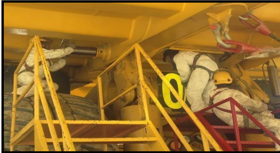
Figura 48: Instalación de pin de tolva LH Fuente: Recolección Propia
