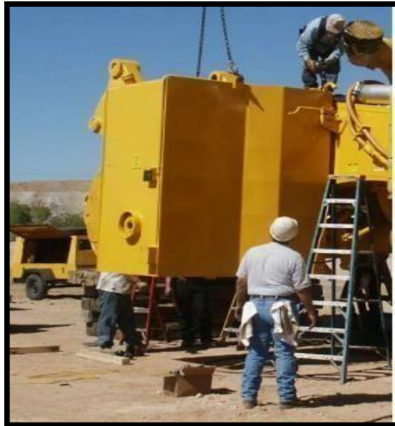
Figura 14: Instalación de tanque de combustible (1400 galones) Fuente: Recolección Propia
