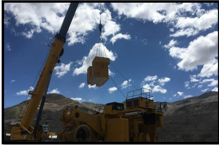
Figura 31: Instalación de gabinete de potencia y control
