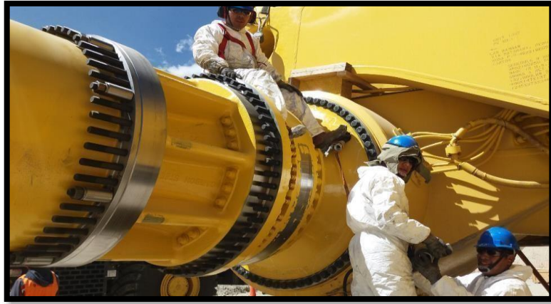
Figura 34: Instalación de mando final Fuente: Recolección Propia
