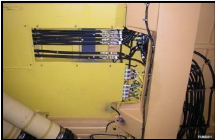
Figura 38: Instalación de líneas hidráulicas hacia cabina del operador
