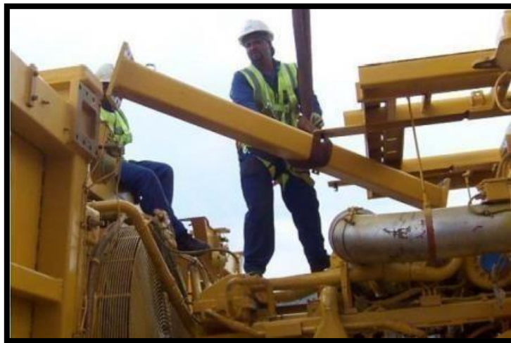
Figura 13: Instalación de diagonales posición LH
