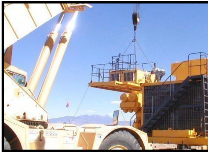
Figura 28: Instalación de banco de parrillas Fuente: Recolección Propia
