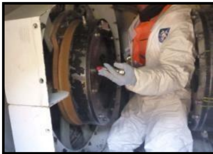
Figura 37: Instalación de freno de parqueo en mando final
