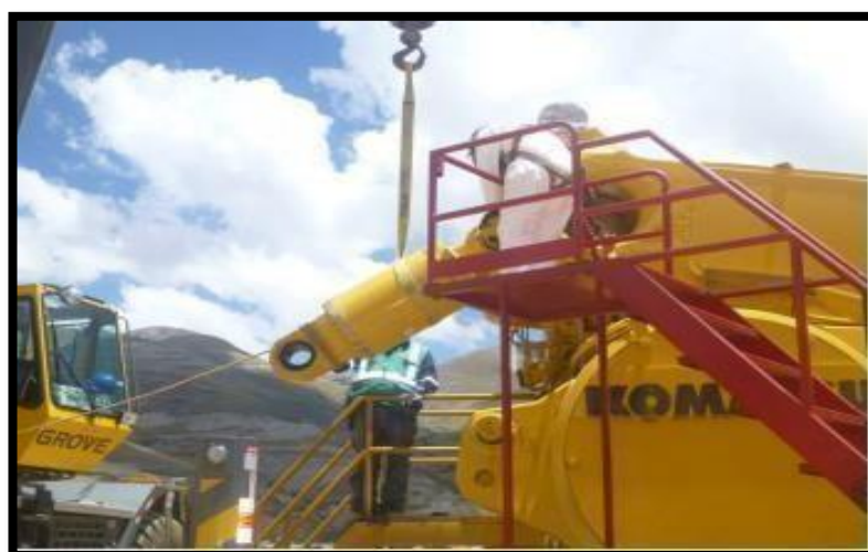
Figura 24: Instalación de suspensión posterior.
