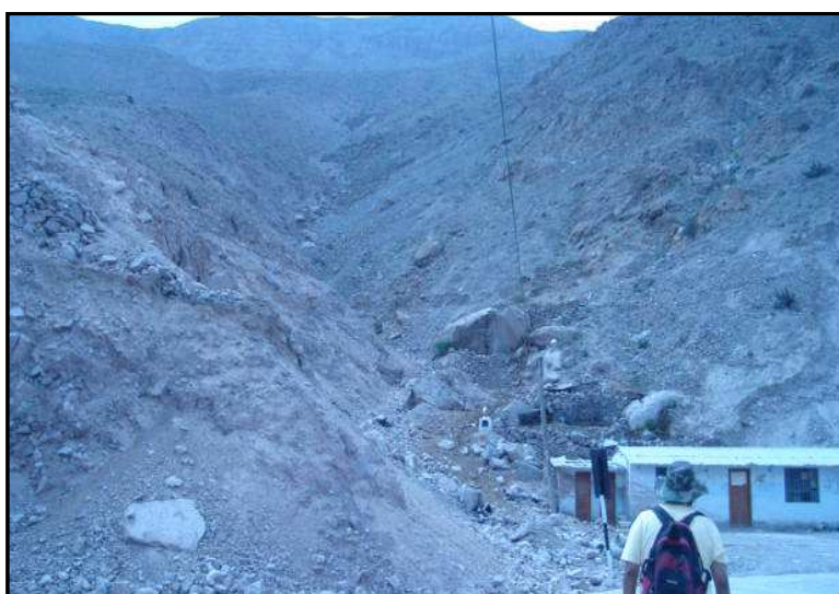
Fotografía No. 7 Depósitos Coluvio – Deluviales y flujos de barro en la desembocadura de la cárcava Alta Misa.
