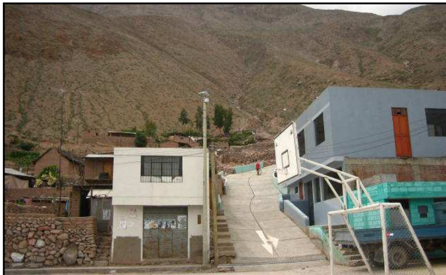
Fotografía No. 9 Parte baja de la cárcava San Bartolomé en cuyo cauce se han construido viviendas y losa deportiva.
