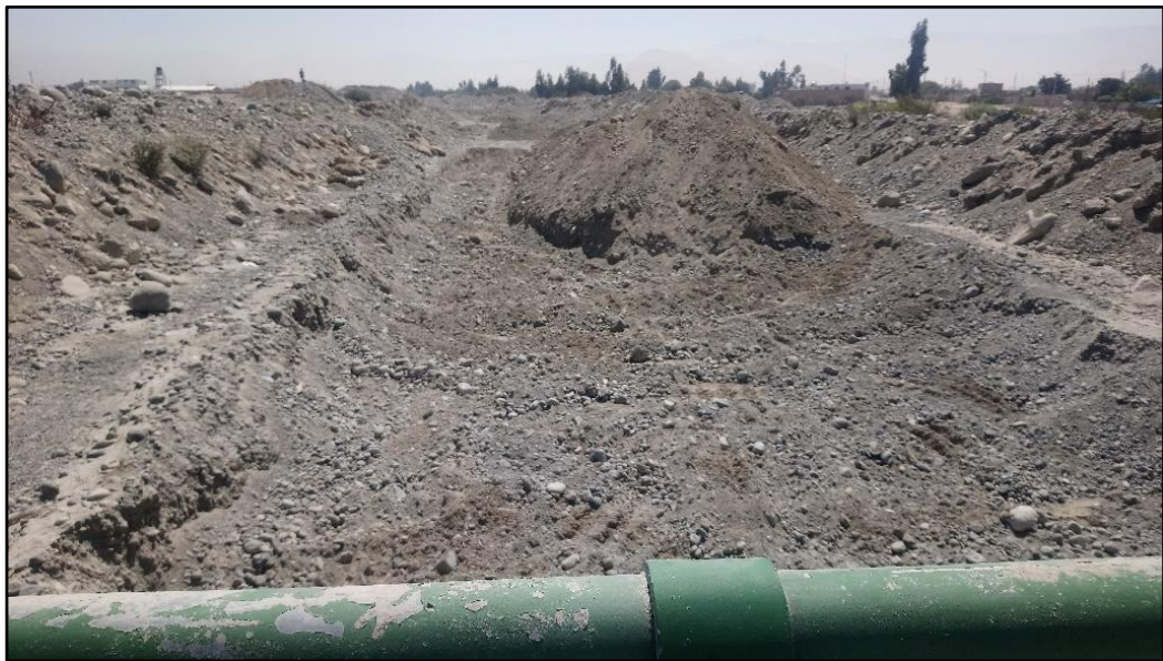
Figura 10. Vista de trabajos de descolmatacion aguas arriba del puente
