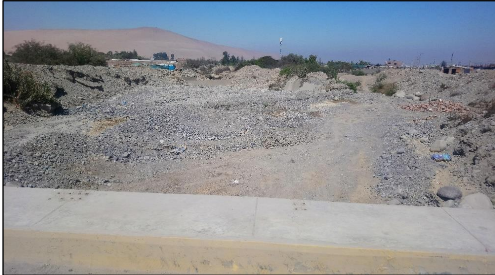
Figura 11. Vista de amplio cauce de río seco, aguas abajo del puente.
