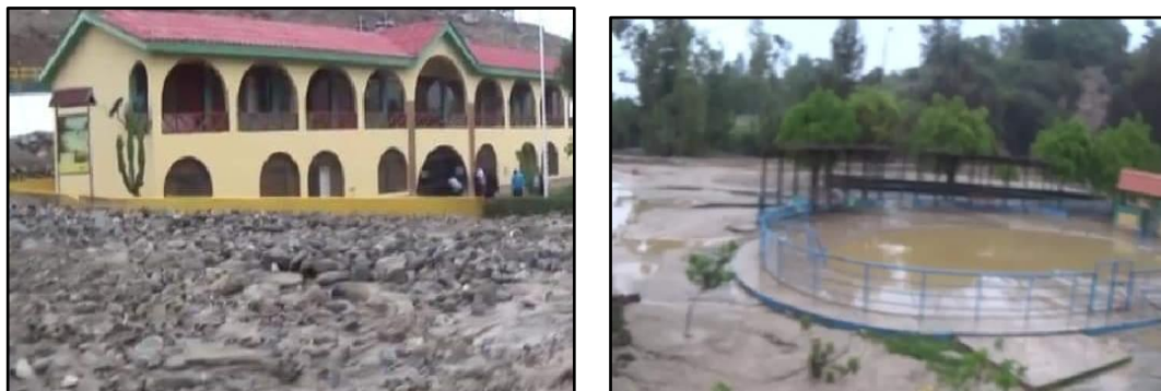
Figura 5. Hotel y piscina en aguas termales del distrito de Pachía afectado por huaico. Fuente. CORREO, 2019.
