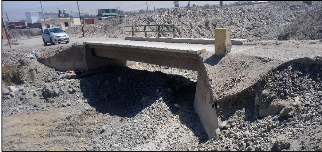
Figura 9. Vista de puente carrozable ubicada a 64.50m aproximadamente desde el eje del puente al límite del terreno en evaluación
