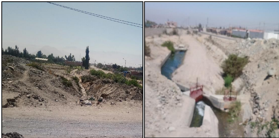
Figura 12. Vista del canal Uchusuma en conducción de agua de riego, además de aguas arriba y aguas abajo debajo del puente
