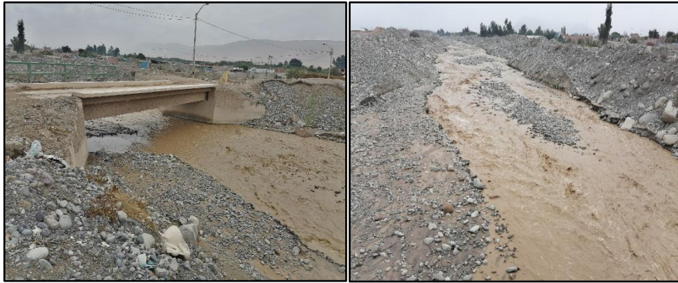
Figura 7. Vista de la operatividad en puente Santa Rita al 31 diciembre del 2020 Fuente. INGEMMET, 2020.
