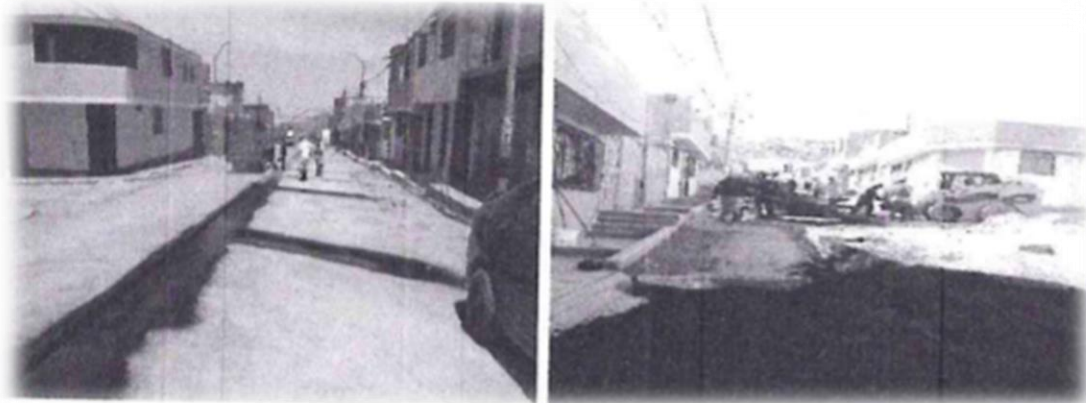
Figura 4. Reposición de pavimento de las principales avenidas y calles.
