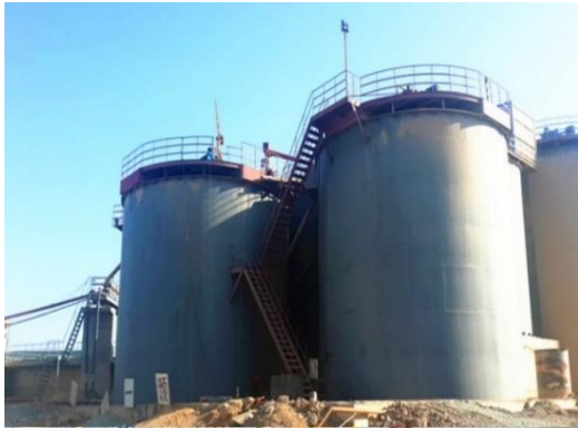
Figura 2 Tanque de lixiviación
