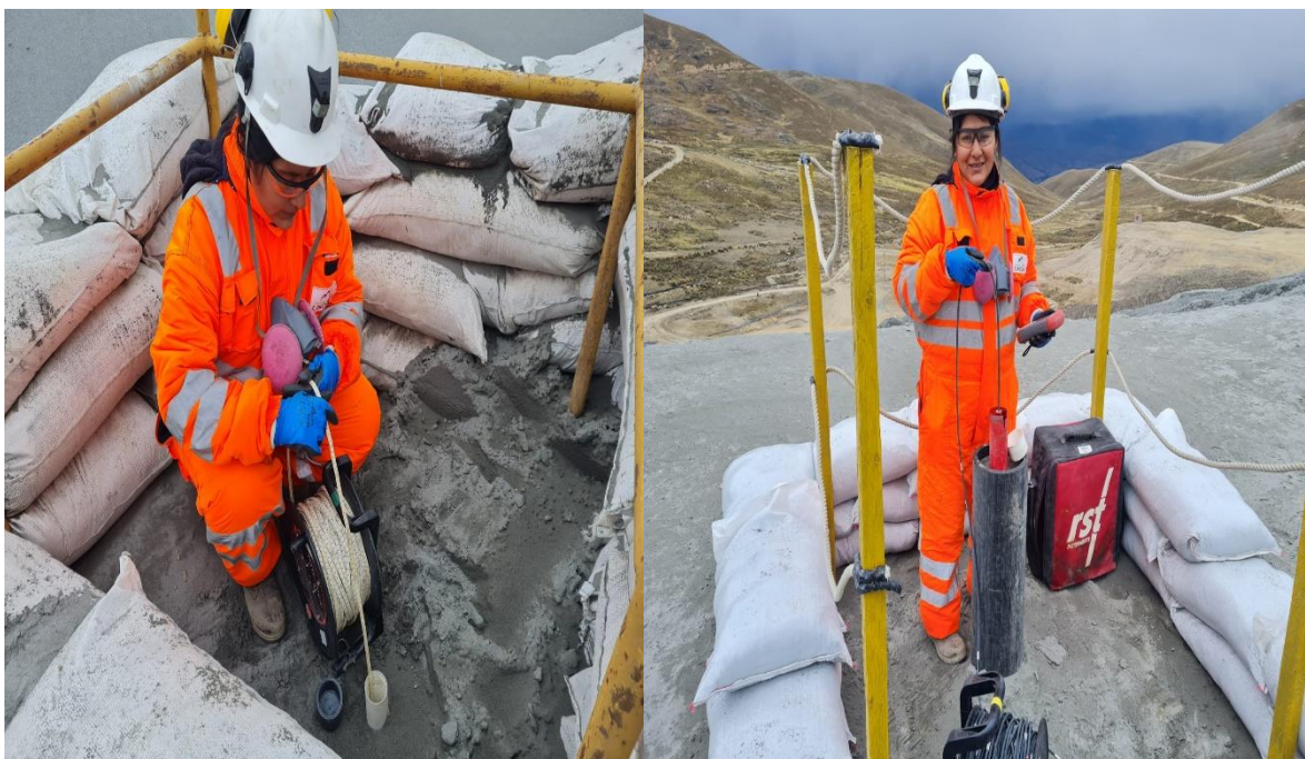
Fotografía 4: Monitoreo de nivel de agua en piezómetros tipo Casagrande.
