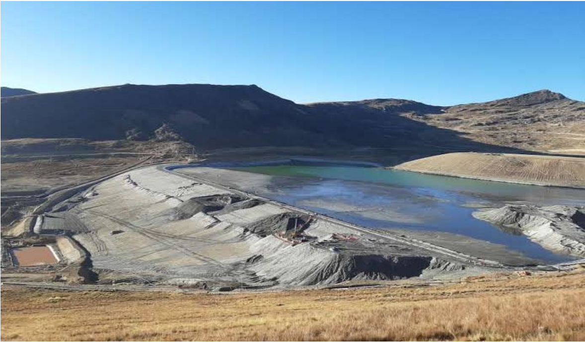
Fotografía 2: Vista panorámica desde la zona este del depósito de relaves.
