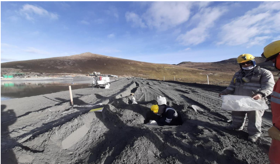
Fotografía 3: Ensayos de densidad in situ en la corona del depósito de relaves.
