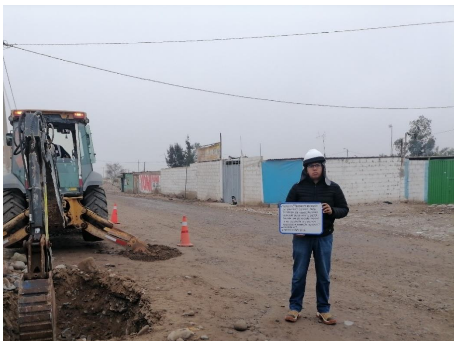
Nota. Excavación de calicata para la muestra N° 2.
