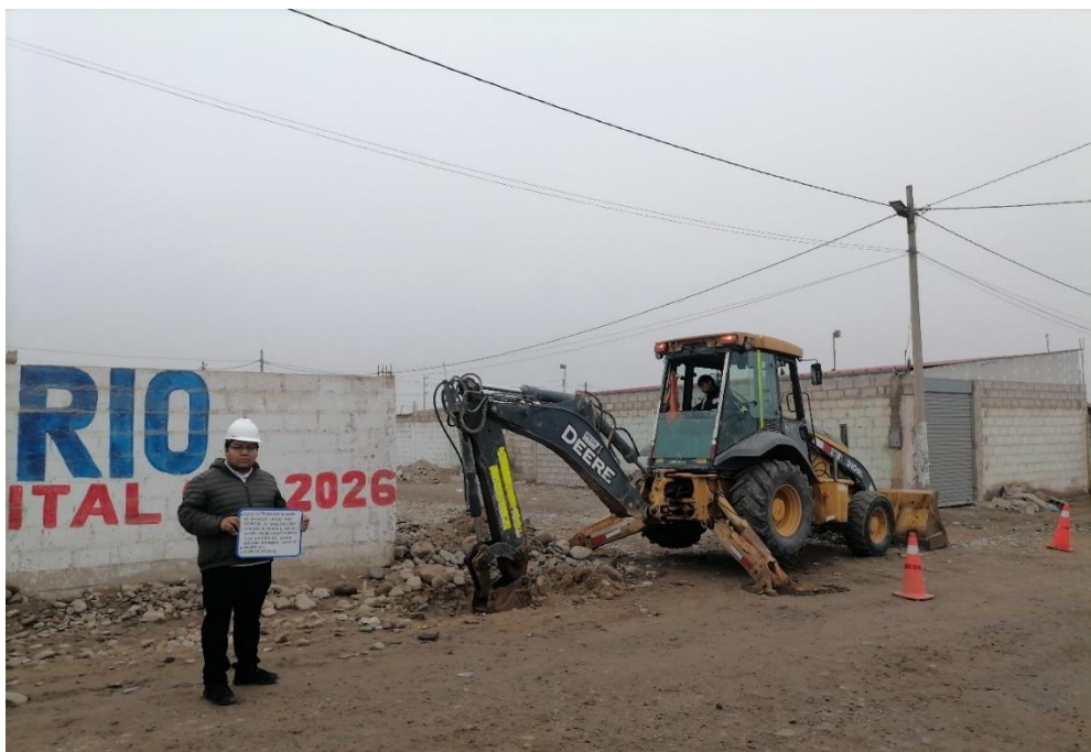
Nota. Excavación de calicata para la muestra N° 1.
