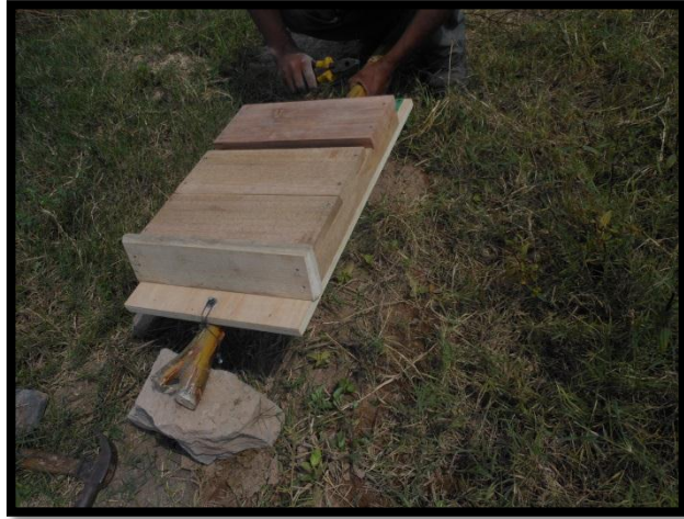
Foto 22. Instalación de refugios artificiales
