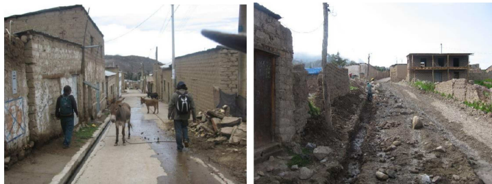
Figura N°22: En mal estado
