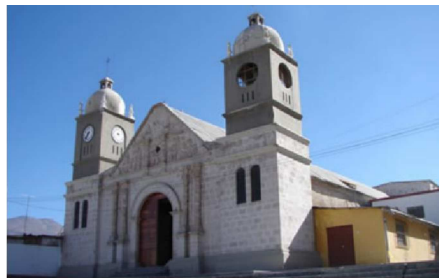
Figura N°47: Fachada de la Iglesia de Tarata
