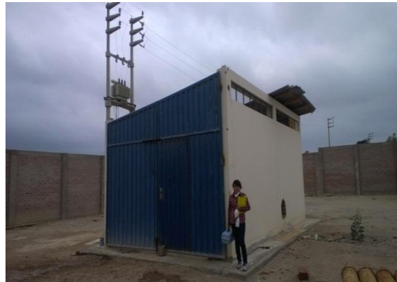
TOMA DE MUESTRA EN EL PV-4
