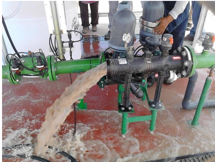
Foto 9. Presencia de impurezas en el agua de riego.
