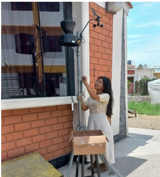
Instalación de la Estación Meteorológica
