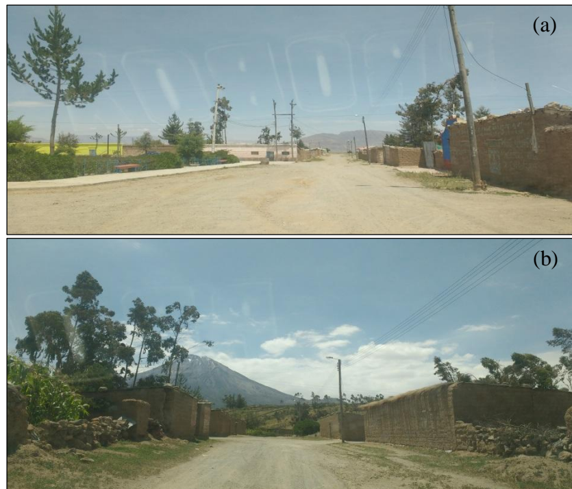
Foto 8.9 (a) y (b) Viviendas construidas de material de adobe y quincha en la localidad de Patatani
