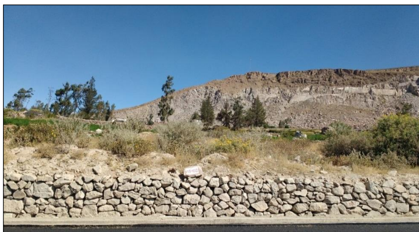
Foto 5.13 Desprendimiento de la Formación Huaylillas en bloques en la localidad de Pallata.
