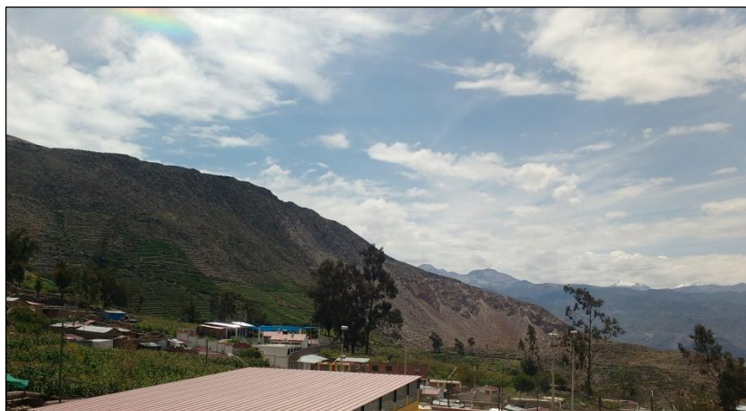
Foto 5.15 Deslizamiento de bloques ubicado en el poblado de Quilahuani.
