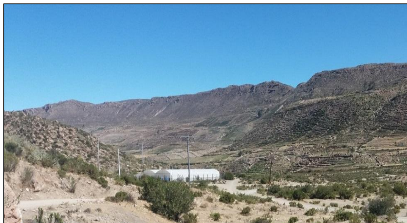
Foto 5.11 Deslizamiento de escombros, en primer plano la localidad de San Pedro.
