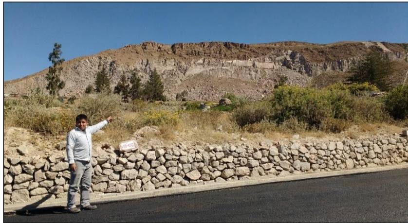
Foto 5.5 Derrumbe de bloques en la localidad de Pallata.
