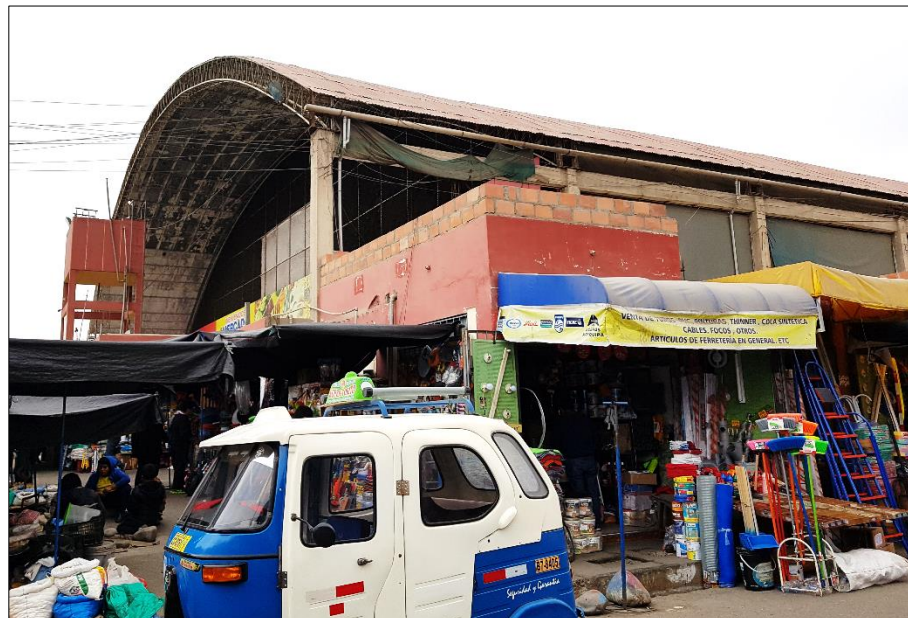
Figura 22: Espacio Exterior del Mercado Santa Rosa
