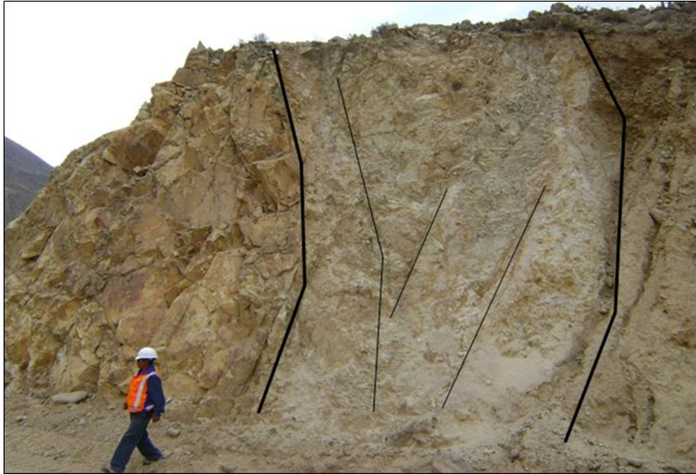
Foto 16. Afloramiento falla Asana, carretera hacia Toquepala pasando el puente río Asana, E 327223,54 - N 8108447,43 Fuente: Autoría propia
