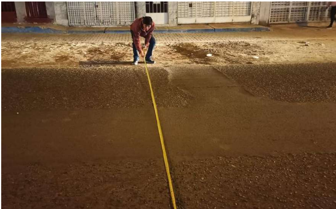
Medición del ancho de carriles en la avenida municipal (intersección 01)
